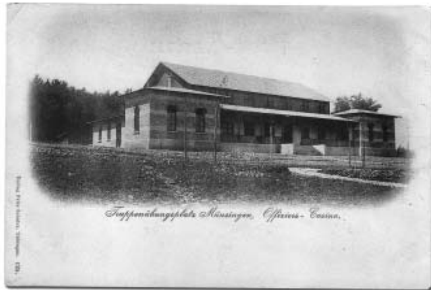
Abb. 9: Foto /Postkarte 1905, Archiv Griesinger Offiziers-Casino des Truppenübungsplatzes Münsingen 1905 mit Schmuckverkleidung aus Böttinger Marmor
